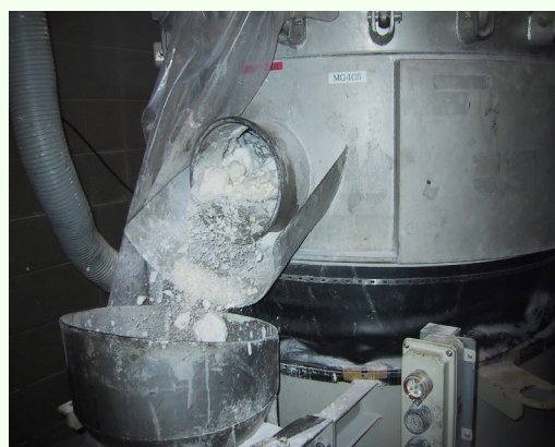
結晶物ろ過 実機 ケーキ排出中
